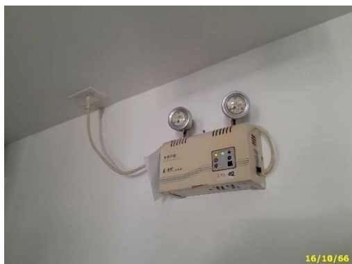
โคมไฟฟ้าแสงสว่างฉุกเฉินติดตั้งบริเวณโถง
